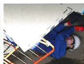
荷の転落による災害
